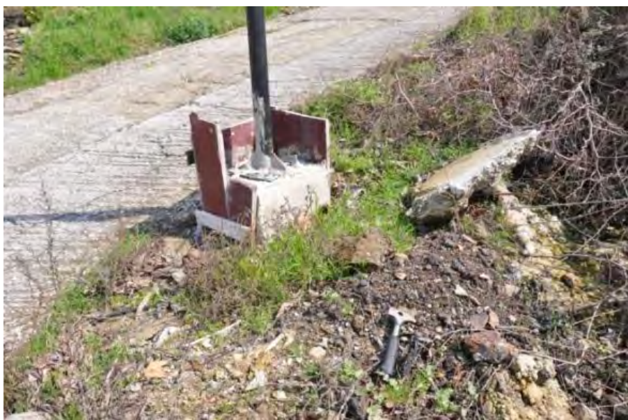
Εικόνα 9.10.1.2 Σκωρίες σε πρανές δρόμου στην περιοχή της μεταλλουργικής θέσης Δωματίων.
