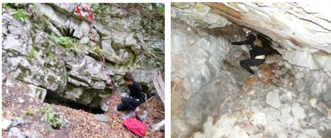
Εικόνα 8.5.4.1. Αριστερά: Άποψη της εισόδου του της υπόγειας στοάς «Τρίκορφο-1». Σημειώνεται κανονικό ρήγμα. Δεξιά: Άποψη του εσωτερικού της στοάς. Στα τοιχώματα της οροφής διακρίνεται ίχνος από την οξειδωμένη μεταλλοφορία που έχει εξορυχθεί.
